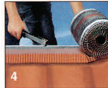
4 Rygningsbåndet hæftes fast
