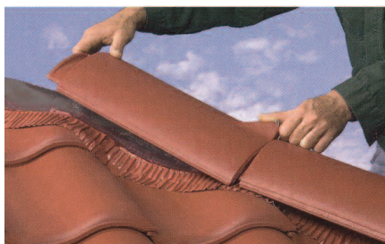
Oplægning af gratbånd og rygningssten
