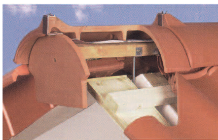
Den færdige rygningsopbygning
