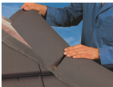
Oplægning af gratbånd og rygningssten
