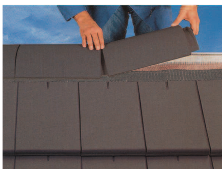
Rygningssten oplægges og fastgøres med rygningsklammer
