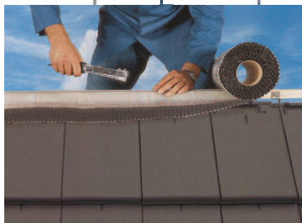
Oplægning og hæftning af rygnings- og gratbånd
