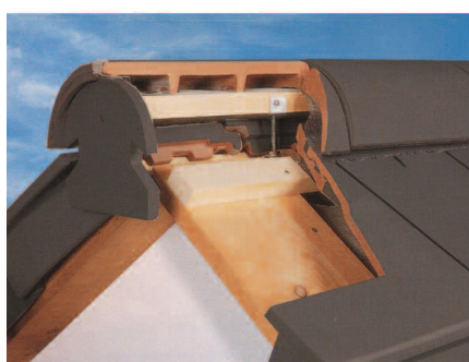
Den færdige rygningsopbygning
