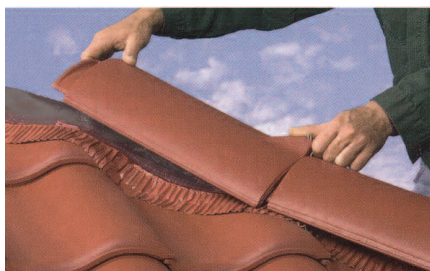
Oplægning af gratbånd og rygningssten
