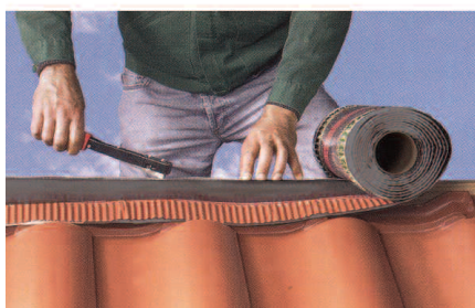
Oplægning og hæftning af rygnings- og gratbånd
